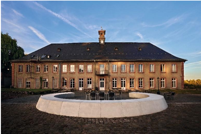
Abb.: Hauptgebäude, Campus Schloss
